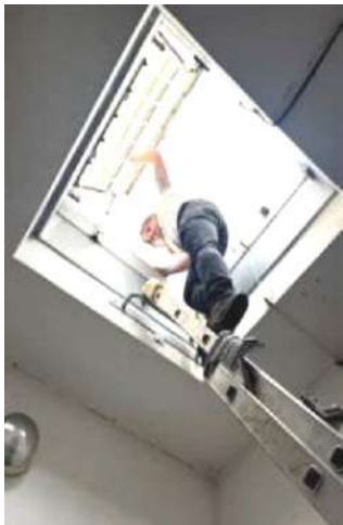
DEVE- Accès à une toiture végétalisée Ouverture-fermeture de la trappe d'une main, absence de prise pour la descente Risque de chute à la montée et à la descente
