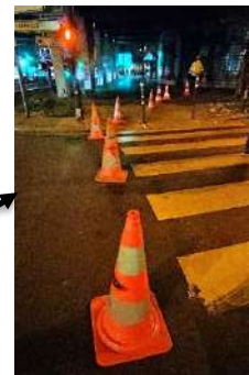
Sécurisation du chantier
